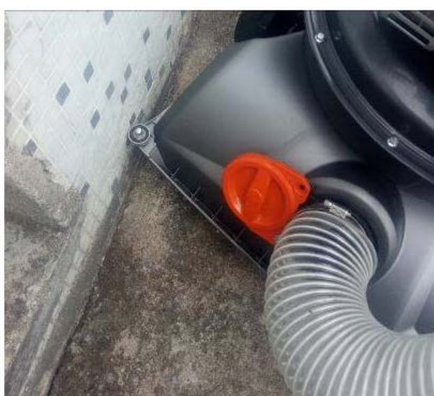
Rys. G-4 Zamontowana rura ssąca
